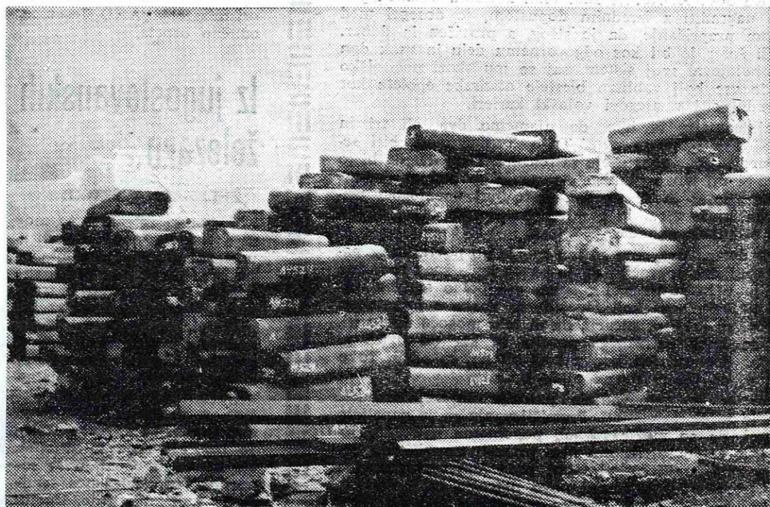
Odkar obratuje nova ASEA električna peč so se povečale tudi zaloge bram, tako da valjarne niso več v stiski za vložek. V jeklarni bodo morali le paziti, da bo tudi kvaliteta bram odgovarjajoča
