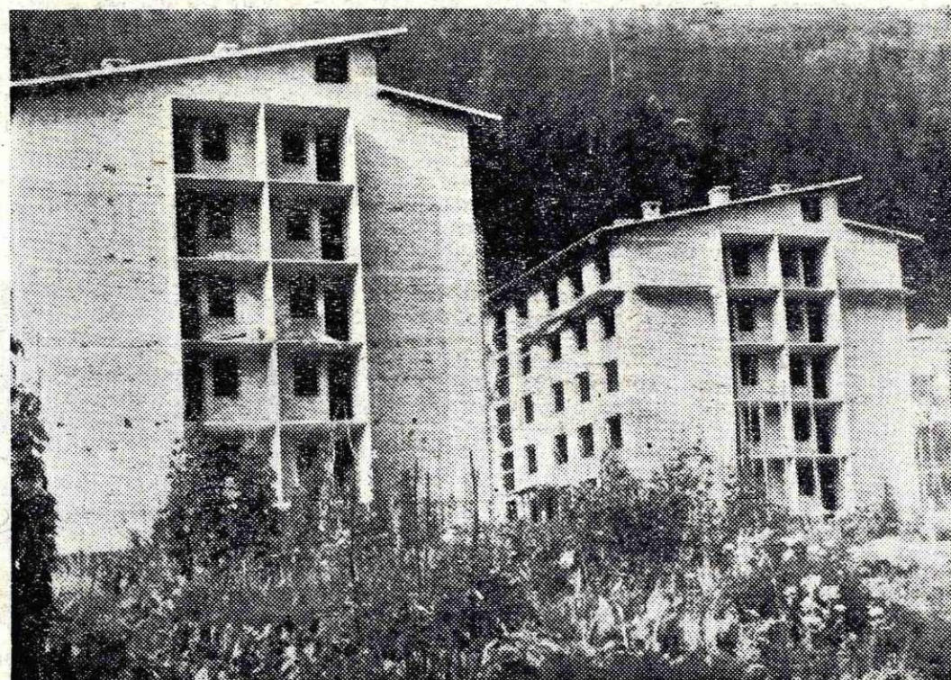
Poleg teh dveh novih stolpičev že kopljejo temelje za še dva
