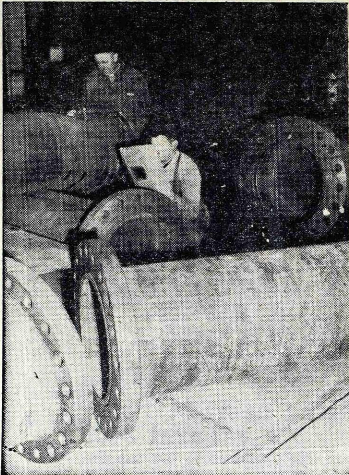
Varjenje visokotlačnih cevi so morali opraviti natančno
