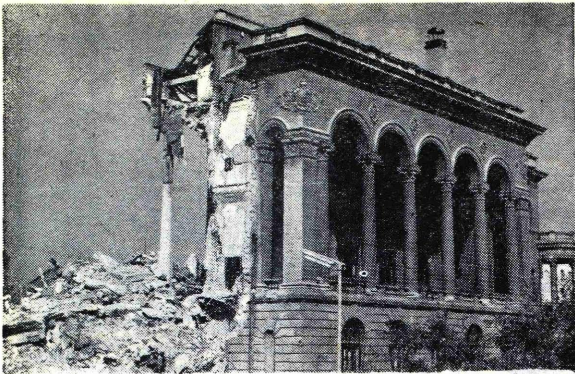
Dom JNA v Skopju je bil prav gotovo med najlepšimi stavbami v mestu. Takoj po katastrofi so bili strokovnjaki mnenja, da stavbe v celoti ne bodo porušili, pozneje pa so ugotovili, da so poškodbe tako hude, da bodo morali dom JNA porušiti.
