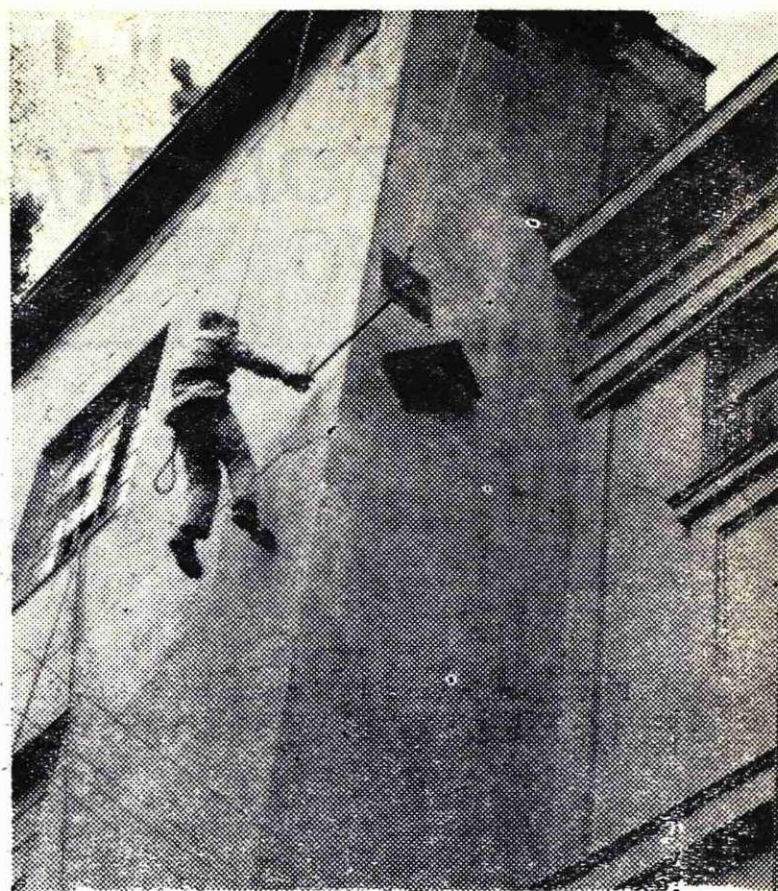
Ekipe rezalcev in varilcev iz naše železarnice, ki je delala pri odstranjevanju ruševin v Skopju, se je več dni mudila tudi v pivovarni. Del tovarne, v katerem so mlini, je bil pri potresu najbolj prizadet in ga je morala naša ekipa zavarovati z jeklenimi vijaki in ploščami. Delo je bilo naporno in zelo tvegano. Naš sodelavec Stanko Belec iz montažnega oddelka je moral viseč na vrveh nameščati in pritrjevati plošče
