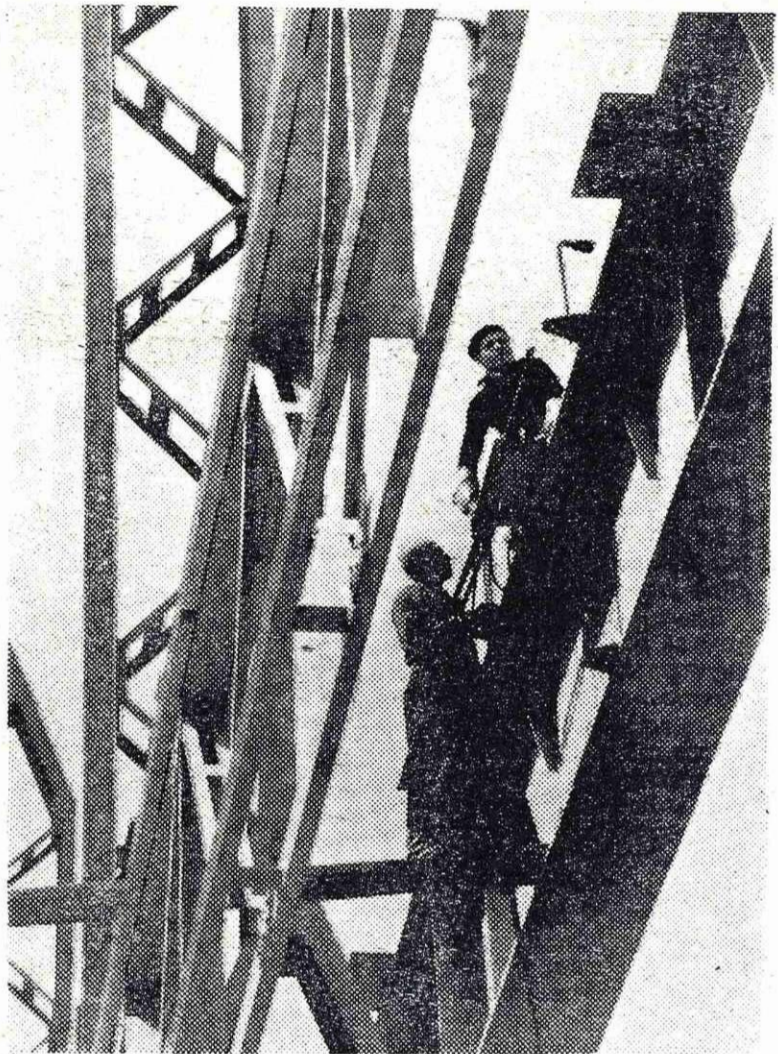
Dela pri montaži, ki jih opravljajo delavci »Metalne«, so izpostavljena veliki nevarnosti. Zavarovani so z varnostnimi pasovi, toda vseeno je minuli teden prišlo do nesreče, pri kateri je izgubil življenje Anton Kovač. Več o tem lahko preberete v posebnem članku
