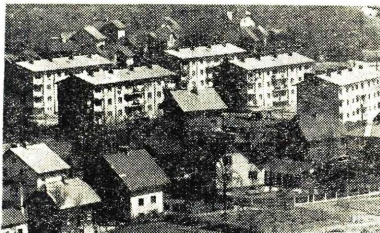
Na nekdanji Čopovi njivi so v lanskem in letošnjem letu zgradili šest novih stanovanjskih blokov. V štirih blokih že stanujejo družine naših sodelavcev, pri zadnjih dveh blokih pa morajo opraviti še zaključna dela
