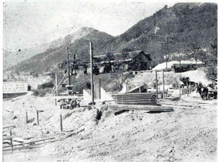
Izkop temeljev za novi most čez Savo
