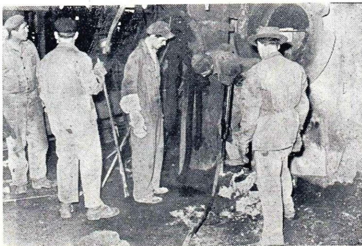
Ob začetku remonta na visoki peči I
