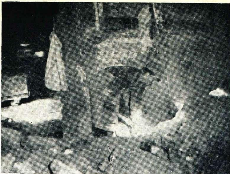
▲ Vroče je pri izkopu SM peči
