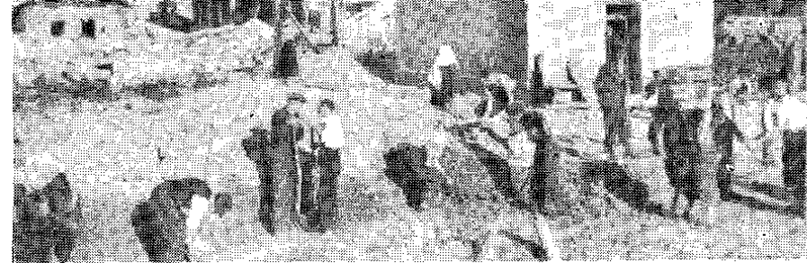
Pričela je obnova porušene domovine
