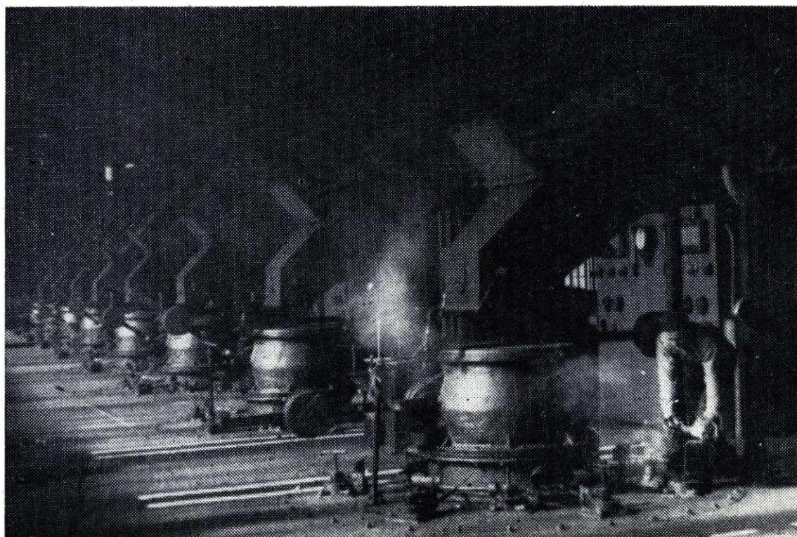
Novi generatorji na Javorniku Foto: Jože Prešeren
