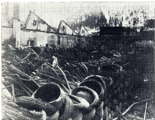
Pred 51 leti je požar uničil predelovalne obrate in močno prizadel tudi našo žebtlarno
