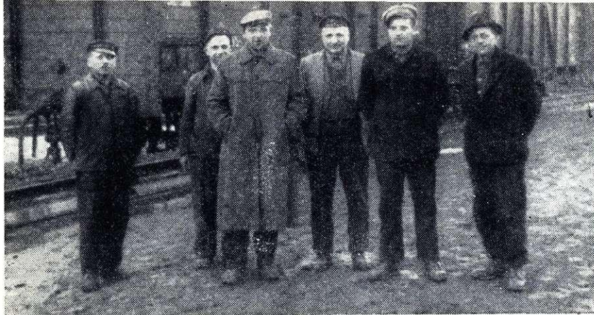
Požrtvovalni in vestni delavci iz prometnega oddelka
