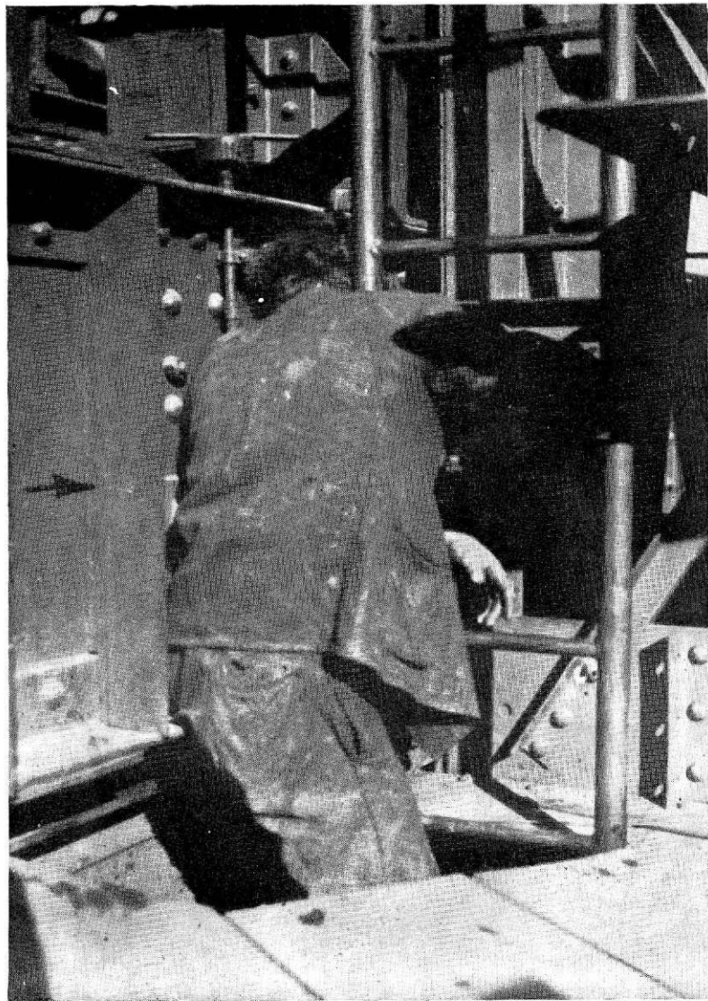
Rekonstrukcija nezgode na žerjavu 3. septembra 1937. Puščica kaže smer premikanja ogrodja žerjava, kjer je sedel delavec in ga je pritislilo ob lestev
