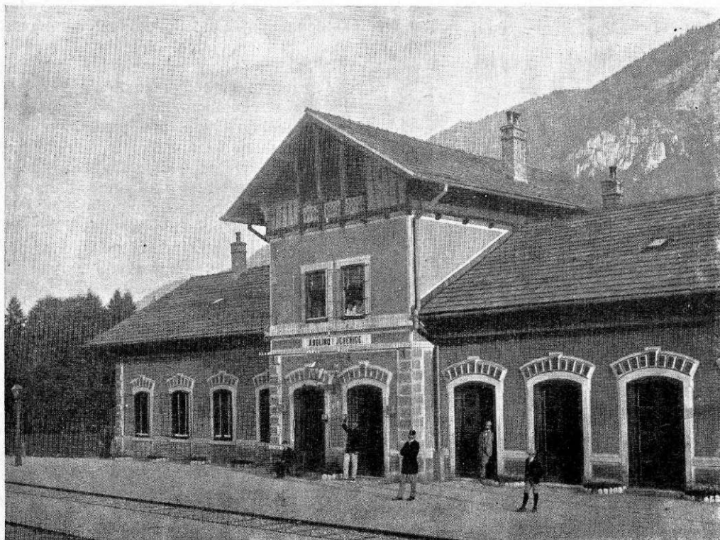
Stara jeseniška postaja — sedaj obnovljeni laboratorij in konstrukcije KID
