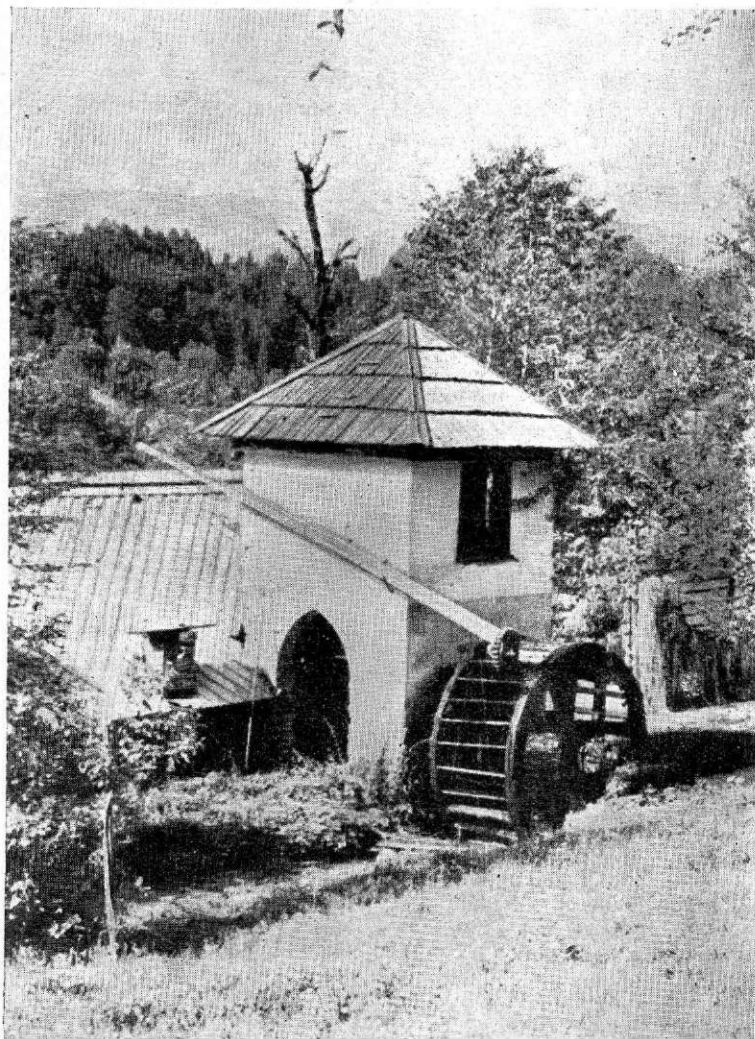
Stara kovačnica v Grabčah ob Radovni. — V naši ožji okolici še edina, ki ima staro kovaško kladivo. Vodno kolo, ki ga je videti na sliki, je kolo, ki je nekđaj gonilo mehove za kladiva starih Zoisovih fužin v Radovni in od katerih je do danes ostalo le nekaj razpadlih zidov. —
