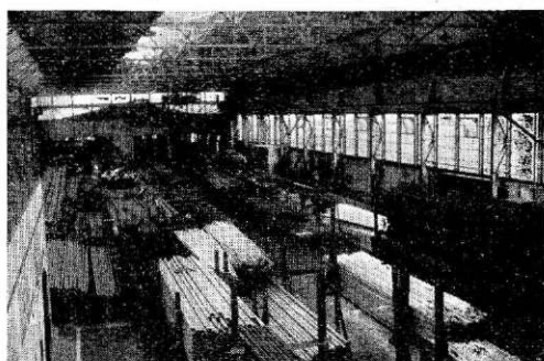
Pogled v notranjost domače tvornice cevi. Cevarna KID na Jesenicah
