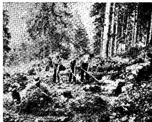
Odkopavanje temeljev gradiča sv. Heme
