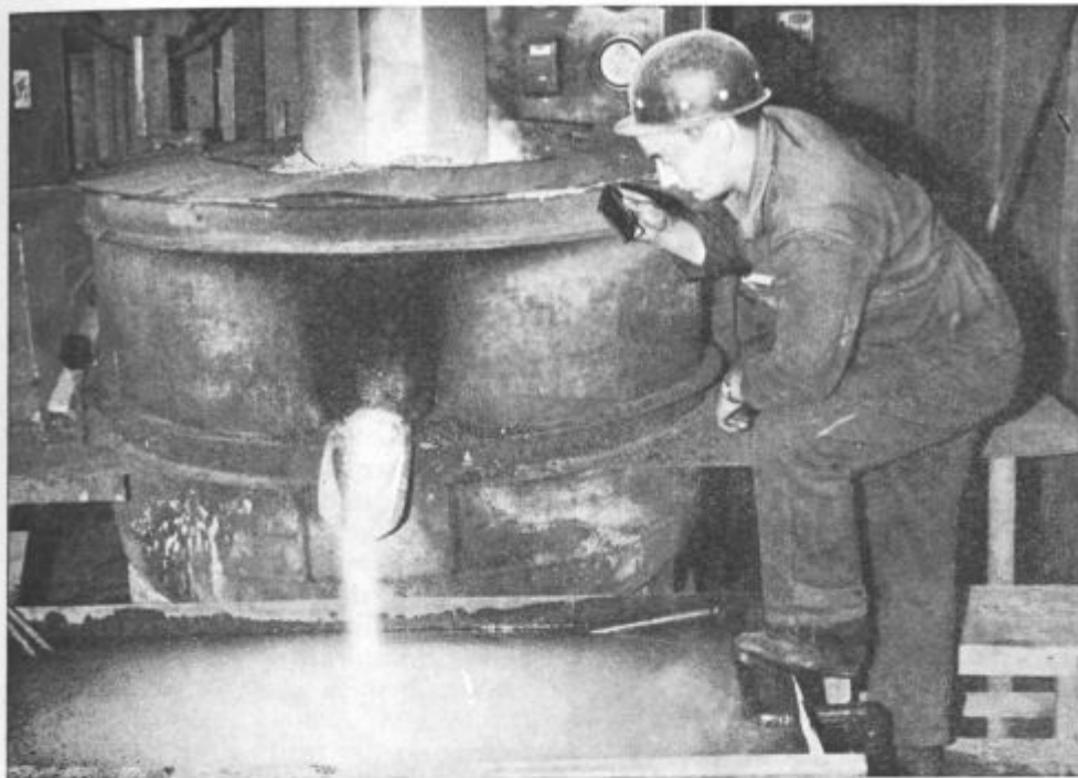
Slika 3 Taljenje in granuliranje praška
