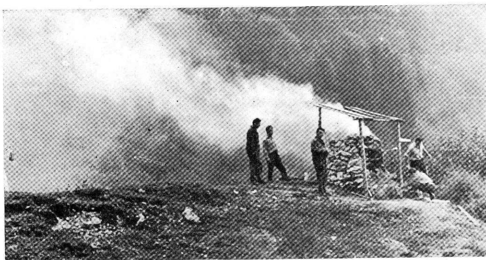
Slika 66 — Vetrna peč je zakurjena
