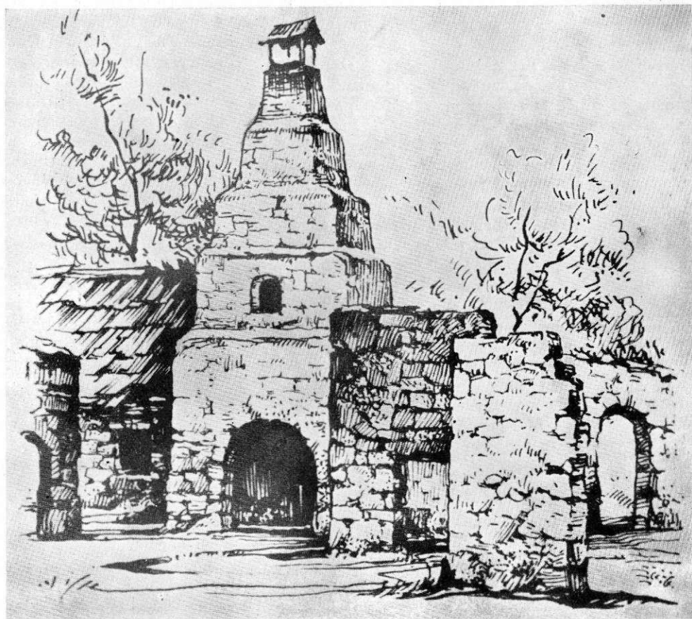
Slika 41 — Tako so izgledale ruševine fužine in plavža po požaru 1890. leta v Bohinjski Bistrici. To je bil zadnji plavž, ki je talil bobovec
