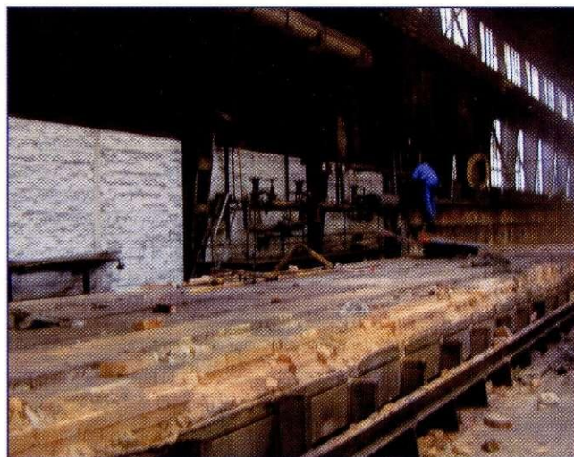
Staro se umika novemu: Podiranje normalizirne peči Custodis. Nastali prostor je predviden za postavitev novega ravnalnega stroja in nove peči za toplotno obdelavo debele pločevine iz nerjavnih jekel.
