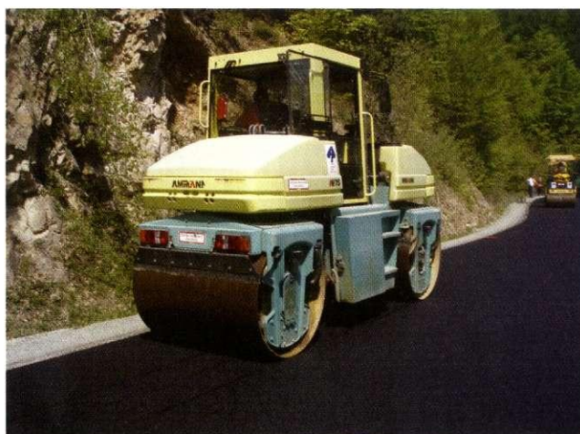
Prvo asfaltiranje z asfaltom, izdelanim z uporabo produktov predelane črne žlindre
