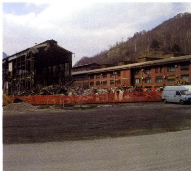
Rušenje glavne stavbe podbojarne – 26. marec
