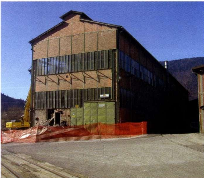
Začetek rušenja – 12. marec
