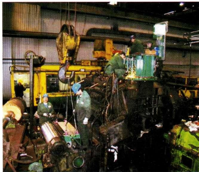
Vgradnja novih elementov sistema
