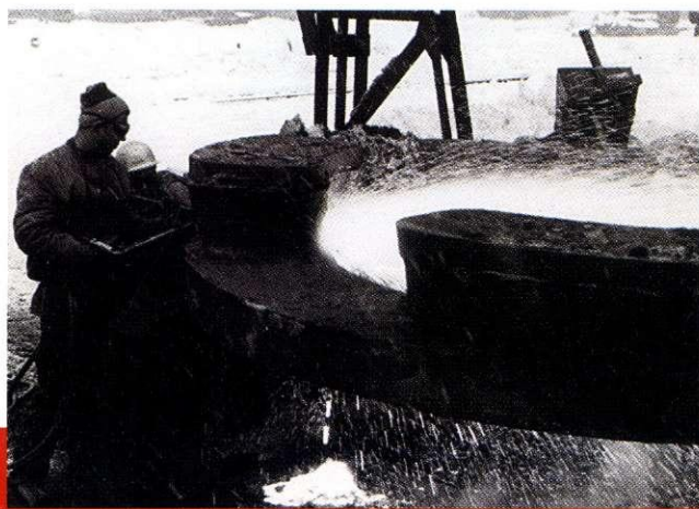
18. 2. 1967 – Avtogeno rezanje jalove glave pri pristanu za hidroelektrarno Srednja Drava
