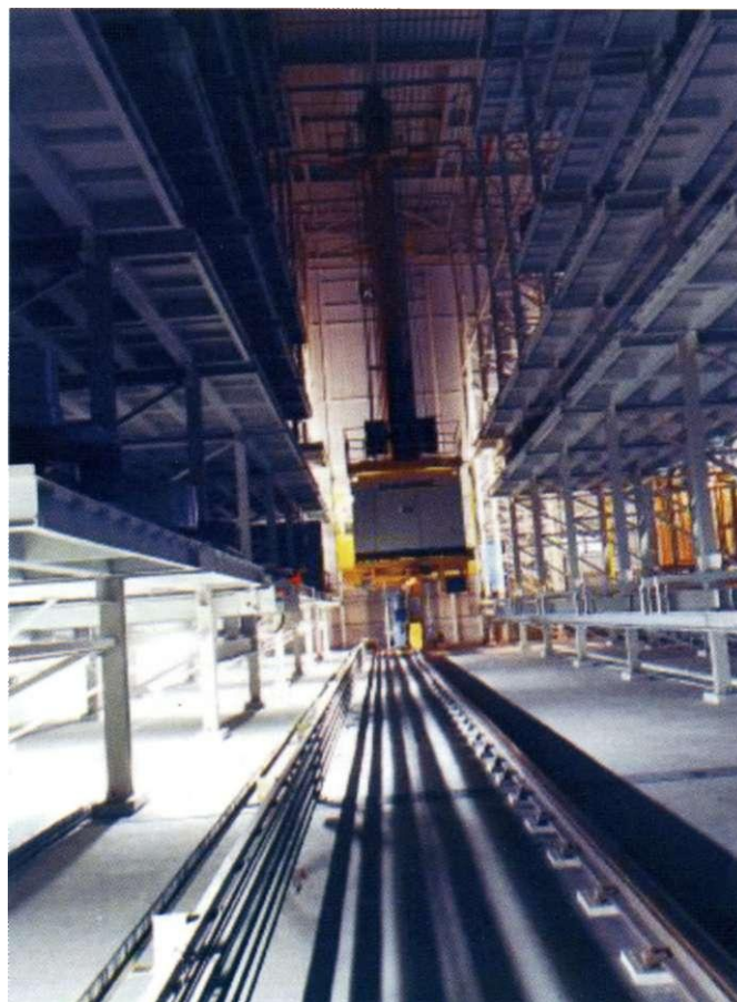
Notranjost regalnega skladišča
