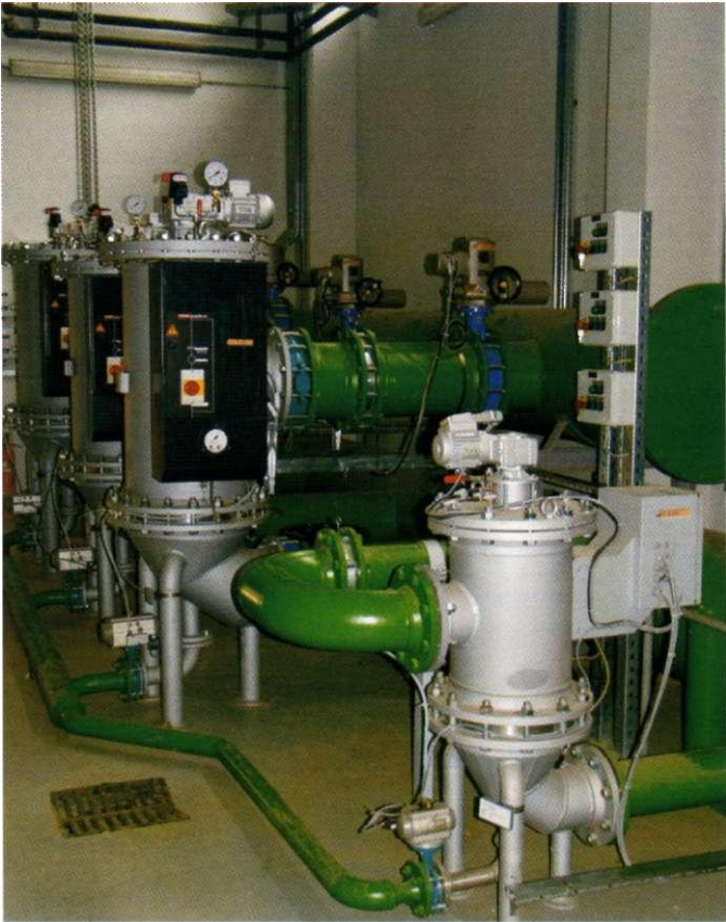
Oskrba s hladilno vodo EP Bela (filtri)
