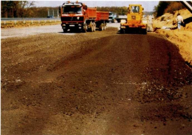
Izgradnja spodnje nevezane nosilne plasti voziščne konstrukcije z uporabo predelane črne jeklarske žindre (vir: BSN GmbH, Kehl-Nemčija)
