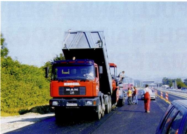
Vgradnja zgornjih obrabnih plasti voziščne konstrukcije izdelanih iz frakcij pridobljenih iz predelane črne jeklarske žindre, ki izpolnjuje zahteve ZTVV Bit.-StB in ZTVT-StB, (vir: BSN GmbH, Kehl-Nemčija).
