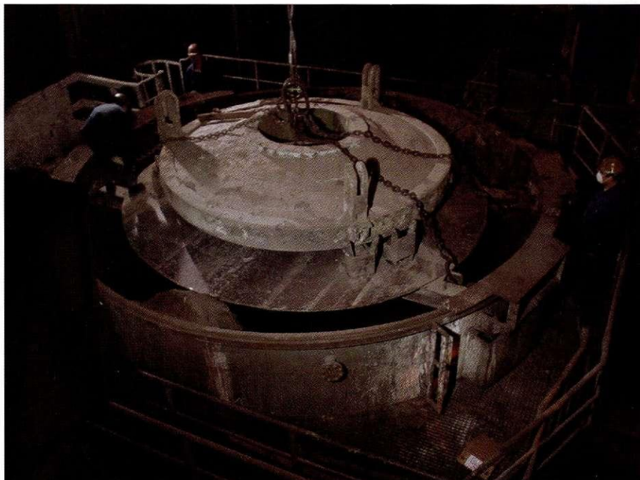
Prvonagrajena inovacija s področja varnosti in zdravja pri delu – nameščanje zaščitnega ščita s posluževalnim podestom
