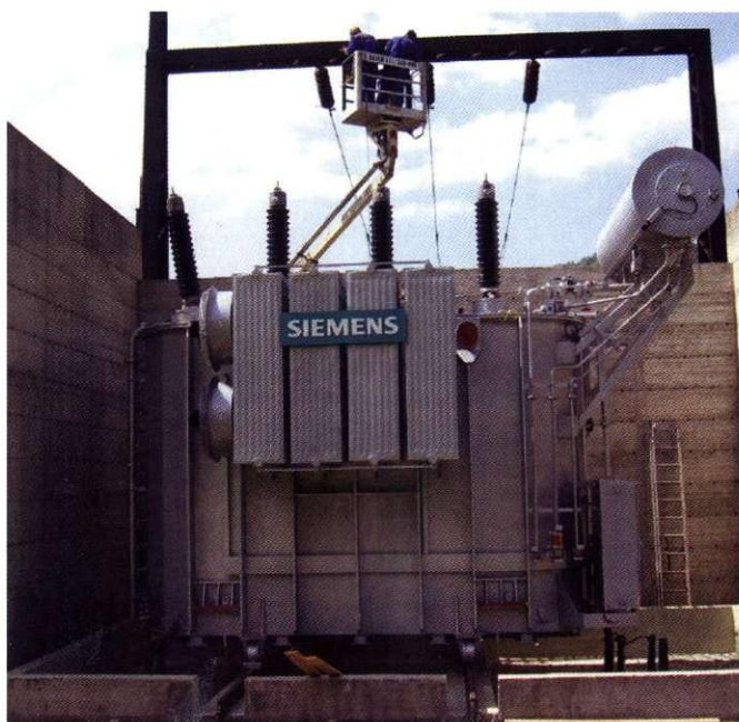
Transformator je pripravljen na priklop.
