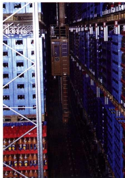
Visoko regalno skladišče v polnilnici.
