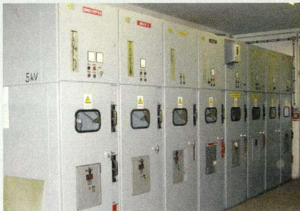
Obstoječe 5 kV stikališče v TP 4 Jeklarna.
