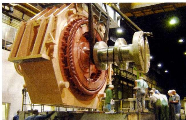
Potek montaže motorja.
