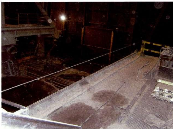
Posebna varovalna ograja na podestu pred vakumsko napravo.
