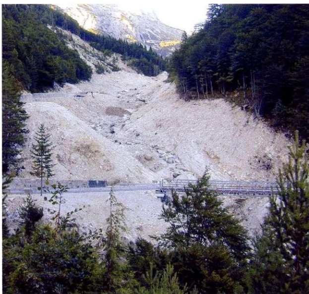
Zemeljski plaz v Logu pod Mangartom - še dolgo bodo vidne posledice
