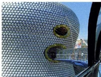
Fasada Selfridges store je izdelana iz platiranih aluminijevih diskov.
