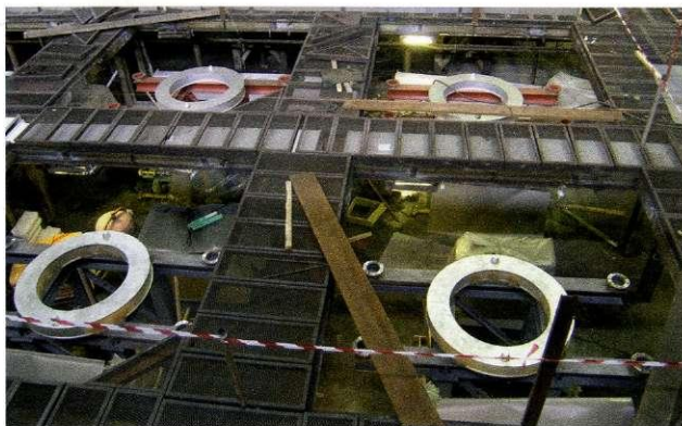
Začela se je zamenjava zvonastih peči v žarilnici Hladne valjarne.
