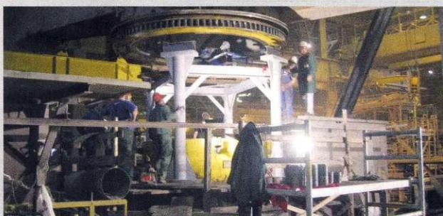
Priprave na obdelavo zgornje površine sedeža ležaja.
