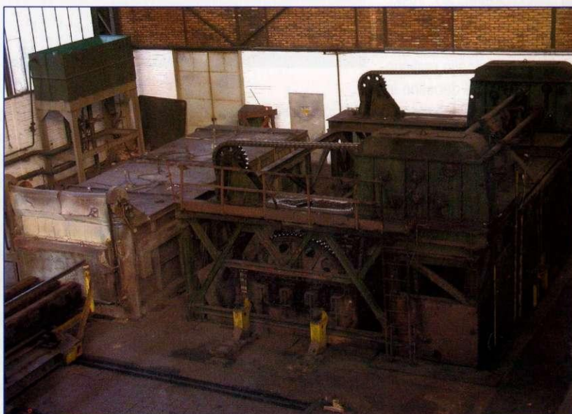
Elektro uporovno kalilno peč Ebner bo zamenjala sodobna plinska peč.
