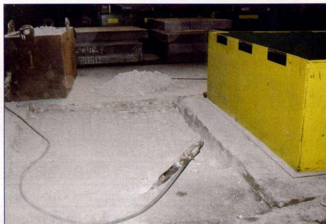
Izravnavanje tal je že v teku.
