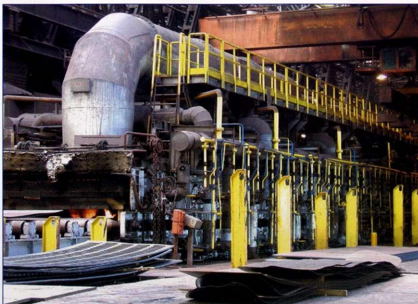
Na liniji Drever je predvidena temeljita obnova.
