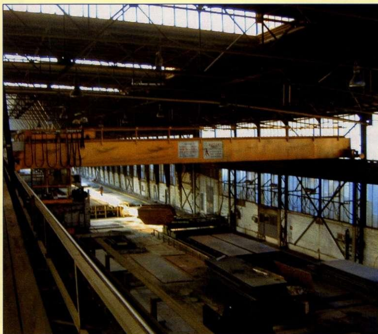
Pogled z žerjavne proge v PDP.
