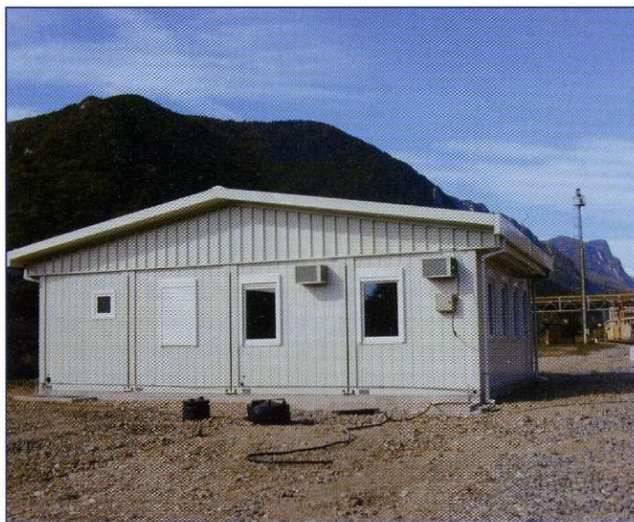
Kontejnerska zloženka, v kateri so delovni in garderobni prostori.
