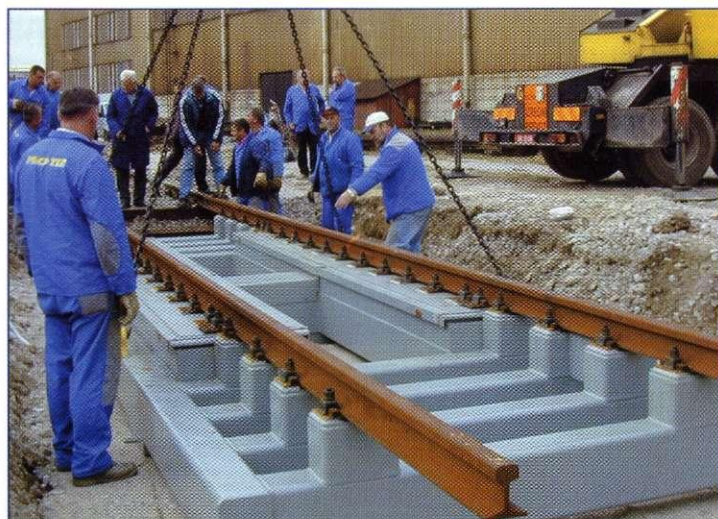
Nameščanje tehtnice med obstoječe tire je natančno in zahtevno delo.
