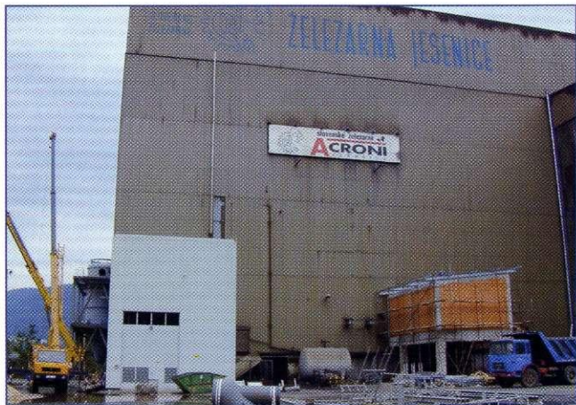
Nova parna kotlovnica je pripravljena za obratovanje. Objekt nove transformatorske postaje se še gradi.
