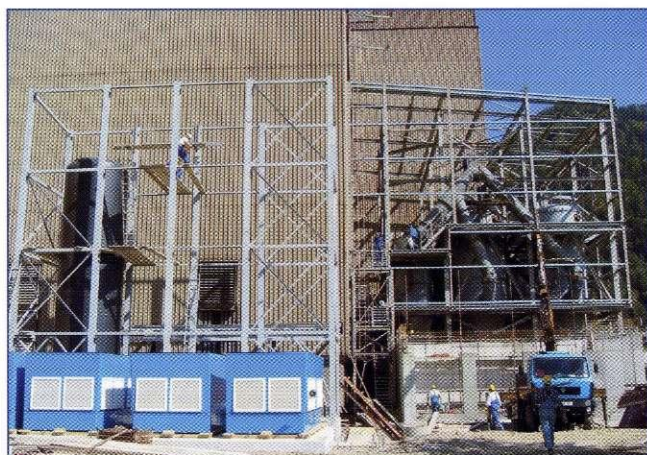
V ospredju so deli zaprtega sistema za hladilno tehnološko vodo, pripravljeni za montažo. V ozadju se montirajo hladilniki plinov in vrečastih filtrov, preko katerih se bodo čistili plini iz nove in stare VOD naprave.
