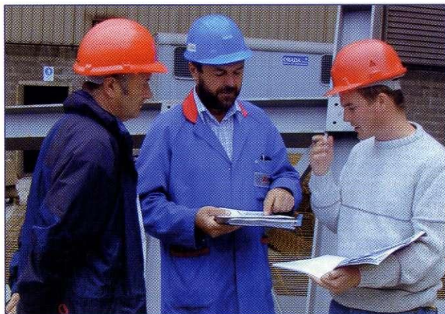
Dela na projektu modernizacija VOD naprave vidno napredujejo. Vgrajenih je že veliko sestavnih delov. Vsak dan je potrebna koordinacija na gradbišču za sprotno reševanje težav in usklajevanje dela med različnimi izvajalci.
