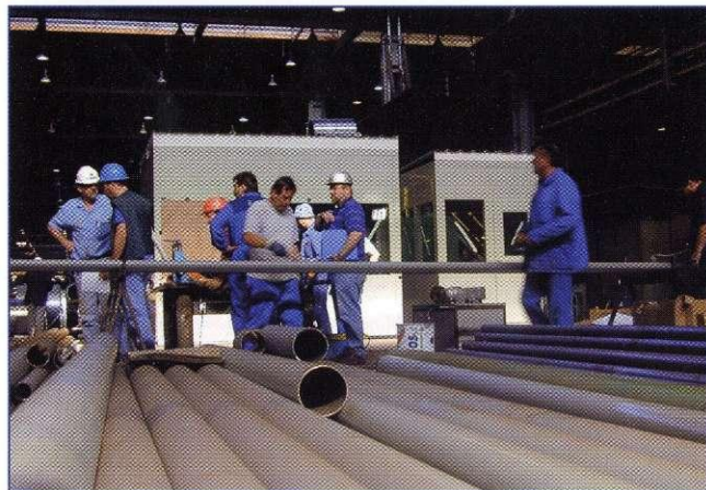
Priprava novih cevovodov.
