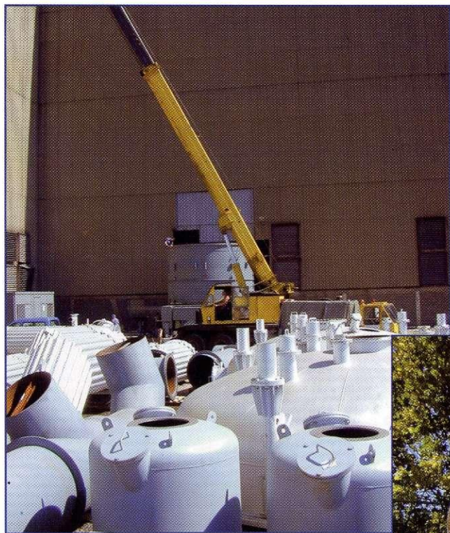
Fotografija spodaj: Stolpi za hlajenje plinov odpraševalne naprave VOD.
