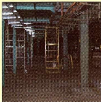
Prilavljalna dela za rekonstrukcijo linije Cmo so v polnem teku.
