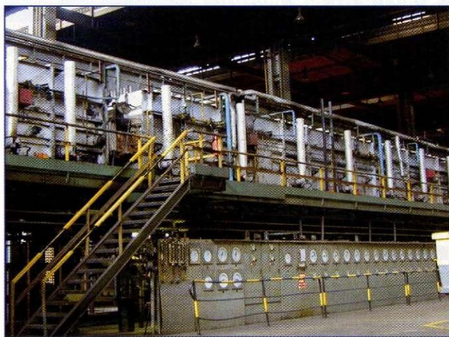
Zadnji posnetek linije pred rekonstrukcijo.
