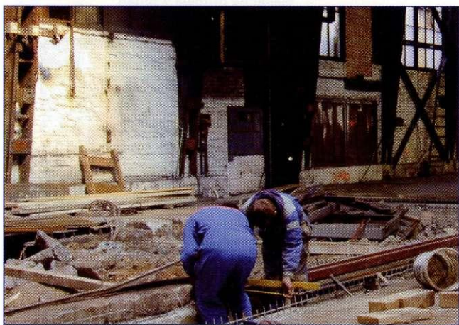
Priprave na postavitve novega ravnalnika.
