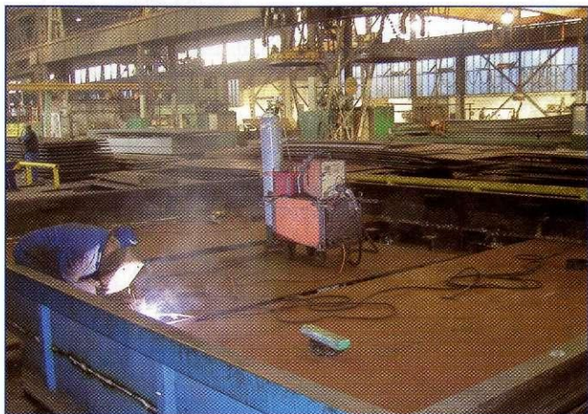
Sanacija rezalne mize rezalnika NC3.
