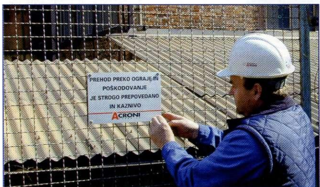
Nameščeni so manjkajoči deli ograje in zakrpane luknje, popravljena mesta pa označena z opozorilnimi tablicami.
