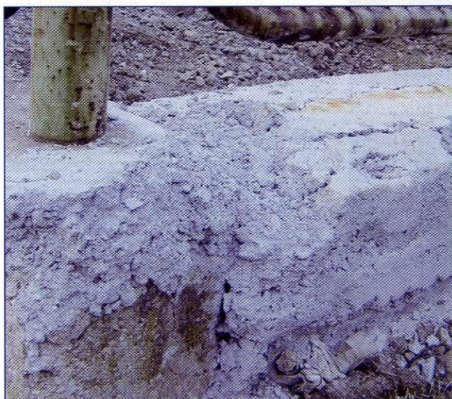
V bližini stanovanjskih hiš, ki mejijo na dvorišče PC Predelava debele pločevine, so bile na popravljenem delu betonskega zidu že naslednji dan vidne poškodbe.
