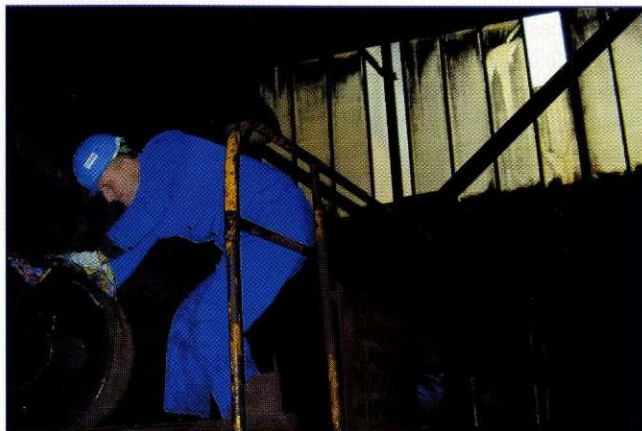
Menjava žerjavnih koles visoko pod stropom vroče valjarne.
