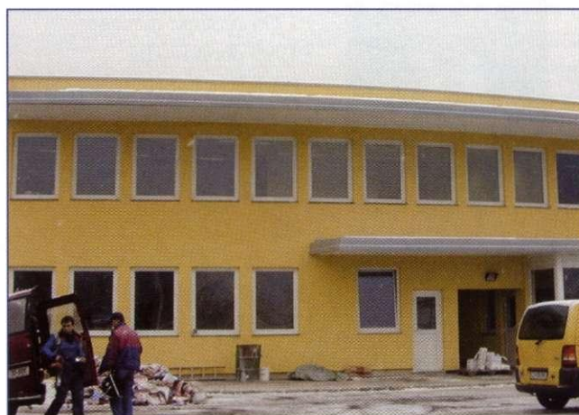
Zaposleni bodo gotovo najbolj veseli novih garderobnih prostorov.
