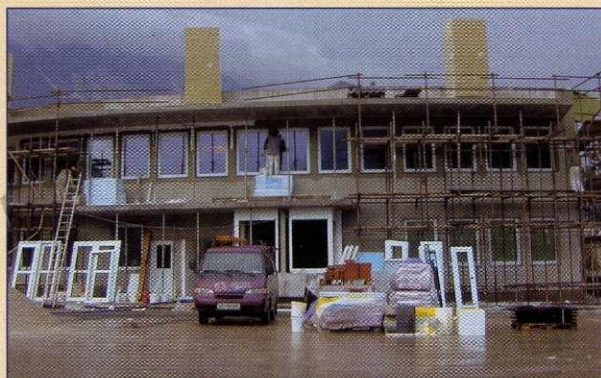
Vstopni terminal in garderobe - vse kaže, da bo gradnja zaključena do roka.
