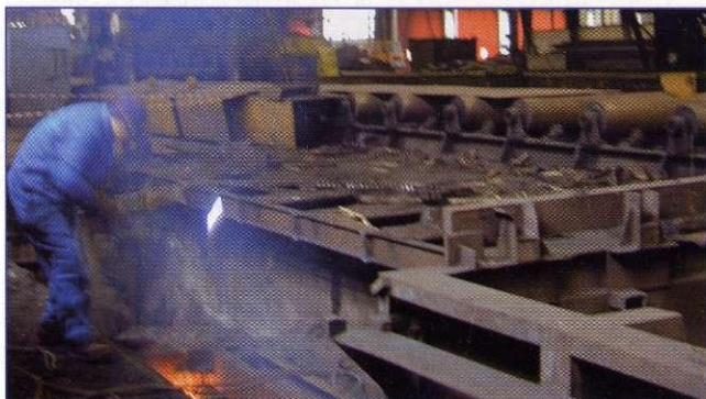
Demontaža prevlačnika Custodis peči.
