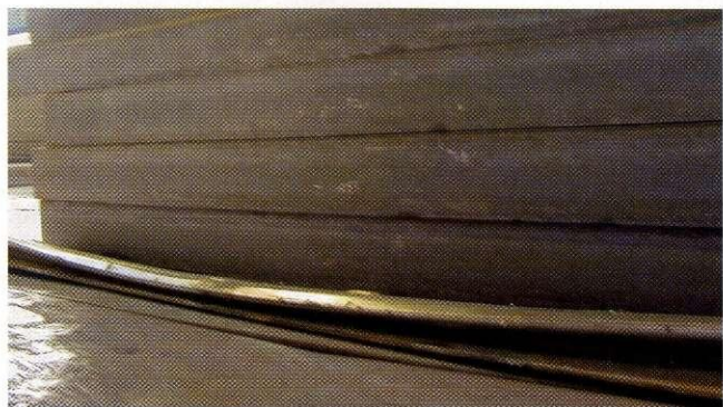
Primer izkrivljenega žerjavnega tira iz 3. hale PC VP.
