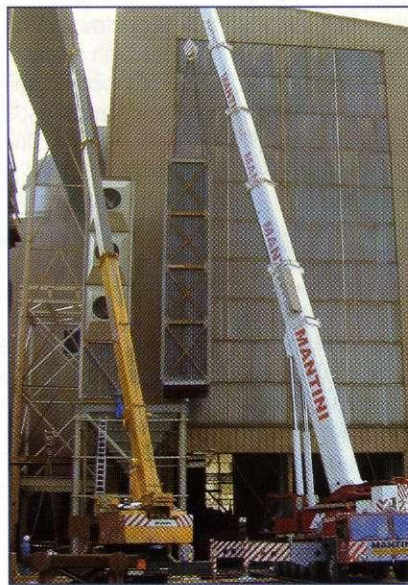
Montaža zračnega hladilnika - najeti je bilo potrebno posebno dvigalo, ki je prispelo iz Italije.
