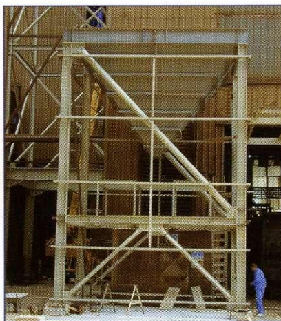
Montaža jeklene podporne konstrukcije za zračni hladilnik in zbiralnik prahu.
