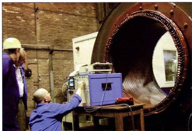
5. junij dopoldne: Pred ugradnjo rotorja je treba izmeriti izolacijsko upornost navitja.
