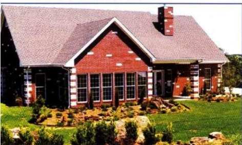
led stanovanjske hiše z jekleno nosilno konstrukcijo.
