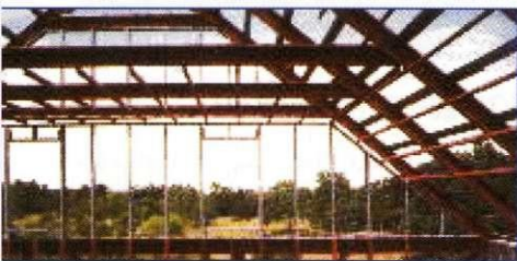
jeklene konstrukcije stanovanjske hiše.
