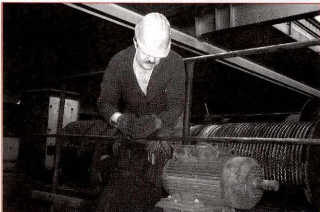
Popravilo žerjava v Hladni valjarni.
