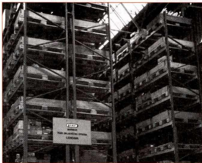
Visoki regali na centralnem prevzemu.
