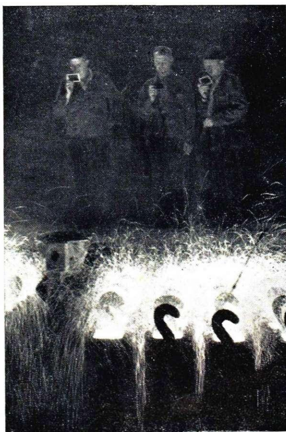
Strokovnjaki - inženirji pri kontroli vlitega jekla v kokilah
