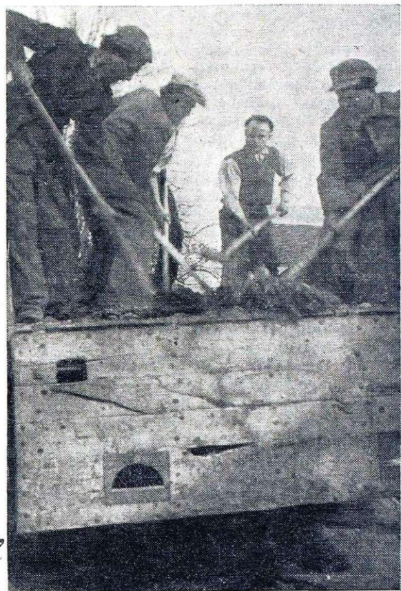
Prostovoljni delavci na delu — pri pripravi za gradnjo združnega doma na Srednji Dobravi, razkladajo material iz kamiona
