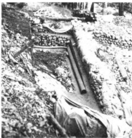
Sanacija vzhodne stene – izpodkopavanje, podbetoniranje z drenažo, razstavljena zunanja fronta z vertikalnimi in horizontalnimi vezmi
