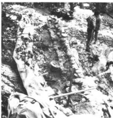
Sanacija vzhodne stene – izpodkopavanje, podbetoniranje z drenažo, razstavljena zunanja fronta z vertikalnimi in horizontalnimi vezmi
