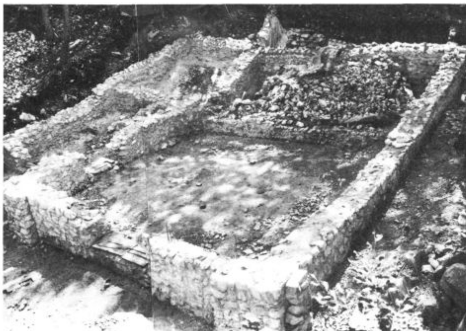
Sanirano obodno zidovje cerkve pred montažo strehe
