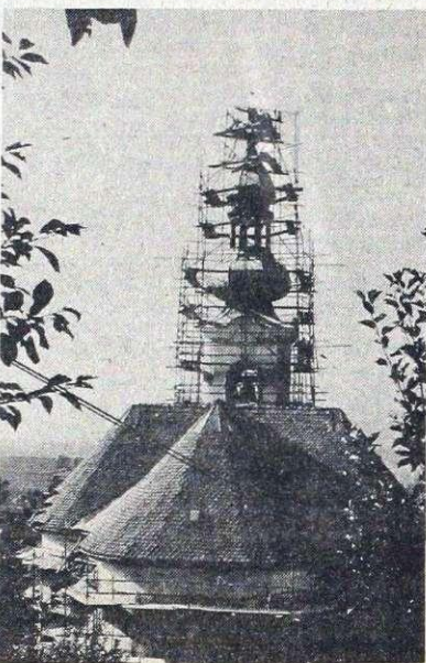
Obnova župnijske cerkve na Koroški Beli (foto: B. Čušin)
